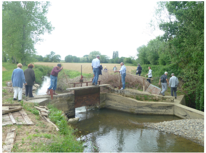
Première vanne déversoir pour réguler le débit du canal. Le propriétaire prend soin de ses hôtes du jour.
