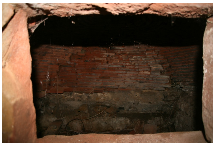
La sole et le dôme endommagés
